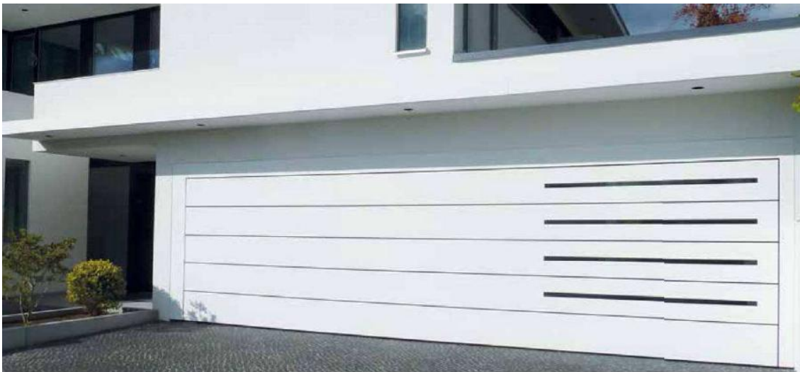
Bauseitige Beplankung mit beschichtetem Glas bei einer Breite von 9 m
