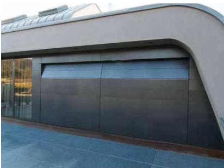
Beplankung mit Alucobond, unsichtbar befestigt
