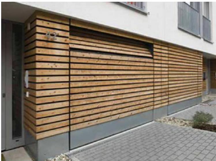
Beplankung mit Holzlamellen
