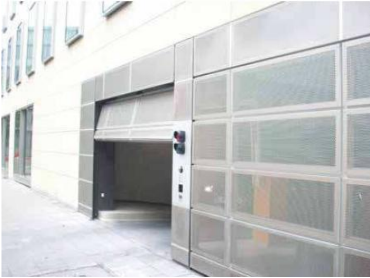
Tiefgaragenanlage, Beplankung mit Lochblechkassetten
