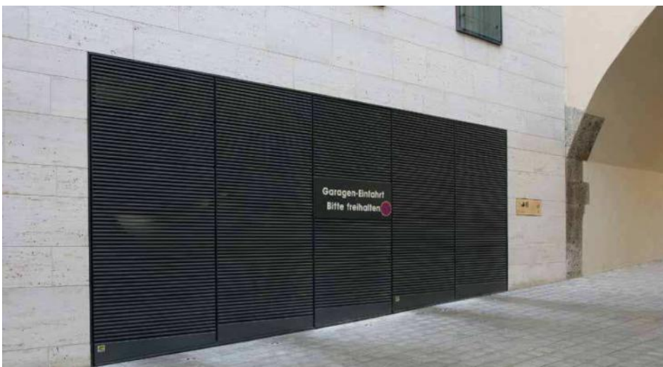
Tiefgaragenanlage, Beplankung mit Lüftungslamellen
